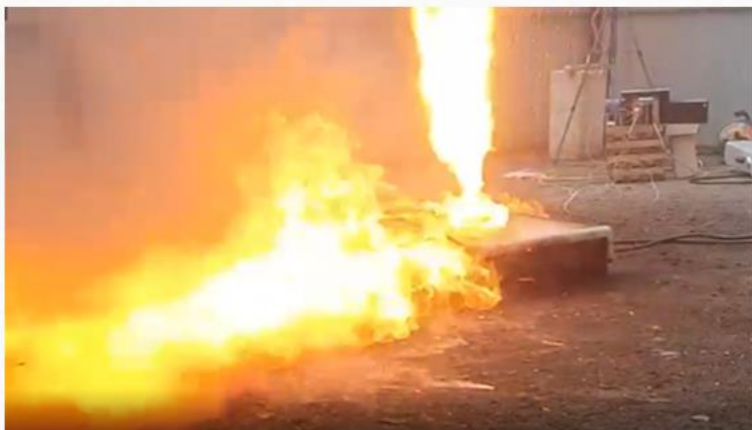
Возгорание группы аккумуляторов в составе батареяного модуля (перезаряд)
