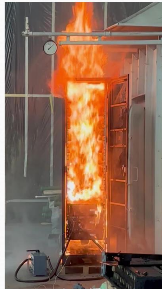
Горение литий-железо-фосфатного кабинета при коротком замыкании модуля
